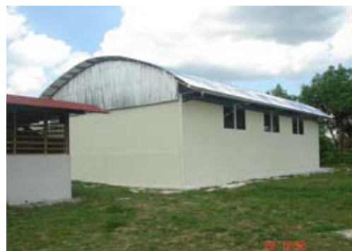
Laboratorio de Investigaciones de Peces Ornamentales construido en el CIQ.
