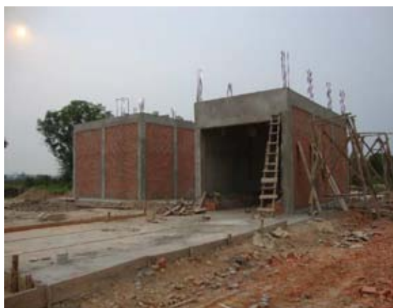
Bases para instalar secadores de madera
