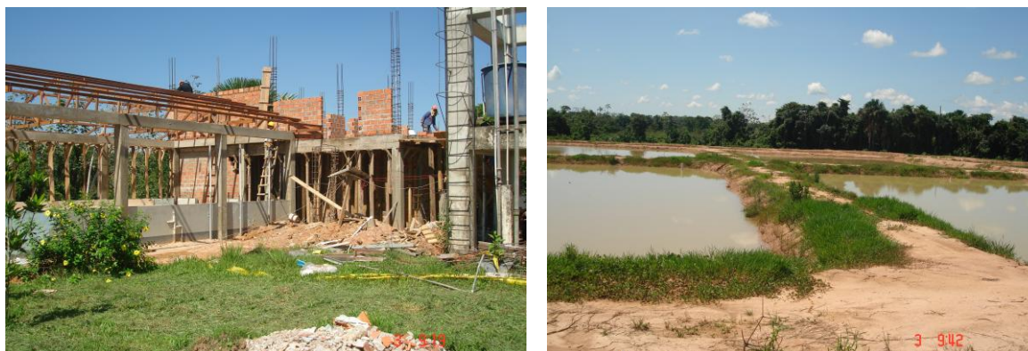
Figura 4. Vistas de la ampliación y mejoramiento de la infraestructura acuícola del IIAP Ucayali (2da. Fase)
