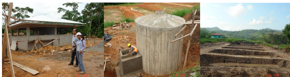
Figura 1. Avance Obra Centro de Investigaciones IIAP San Martín
