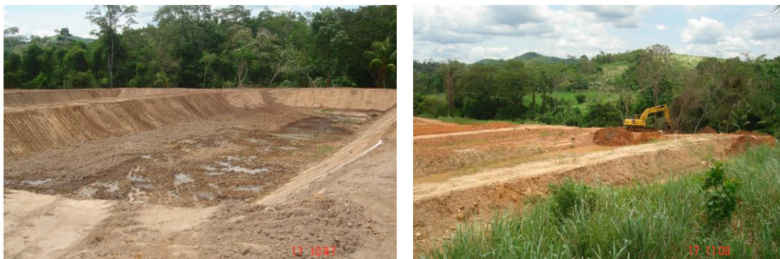
Figura 3. Vista panorámica de las construcción de los estanques acuícolas en Pucayacu (IIAP San Martín)
