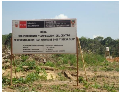
Figura 1. Vista parcial de las obras del complejo de investigación en acuicultura
