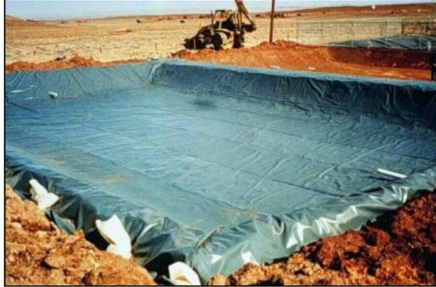
Figura 8. El sitio de la construcción que muestra un recubrimiento plástico sintético para humedales (Purdue 2007)
