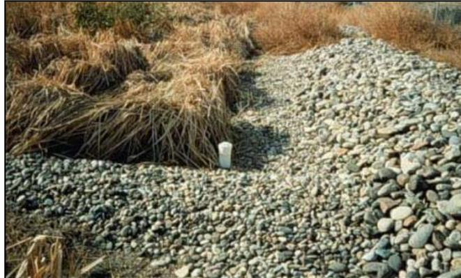
Figura 10. Un humedal construido completa con grava y vegetación (Purdue 2007)
