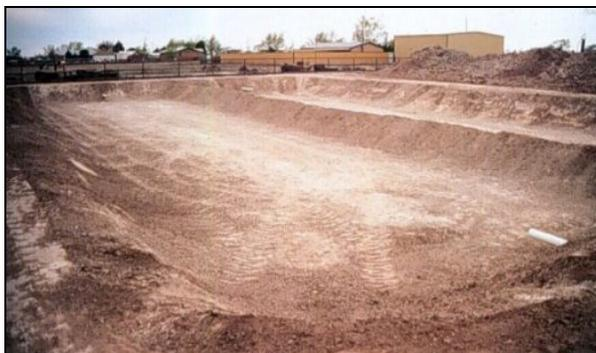
Figura 7. Un sitio excavado y graduado que muestra una cuesta leve (~1%) en la dirección del flujo (Purdue 2007)
