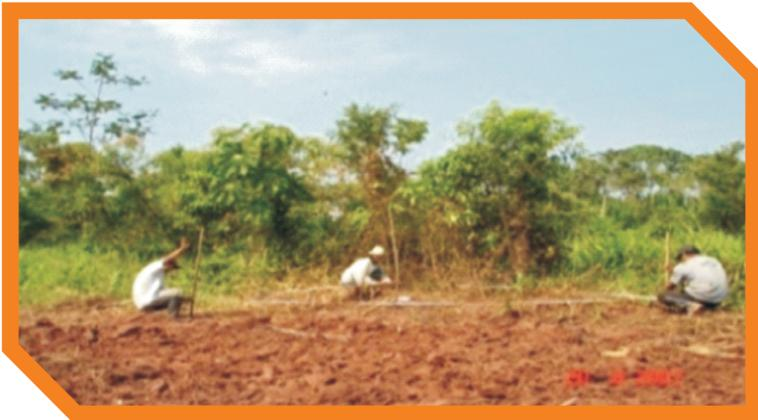
**Figura 18.** Delineado del terreno utilizando el método del triángulo.
